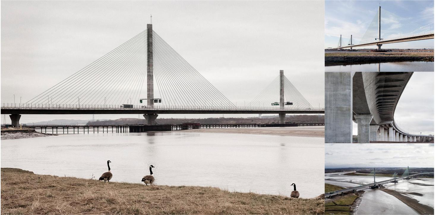
El puente de Mersey es una estructura de 2248 m entre juntas de dilatación, de los cuales los casi 1000 m centrales cruzan el cauce del río Mersey con una solución atirantada singular de cuatro vanos.
